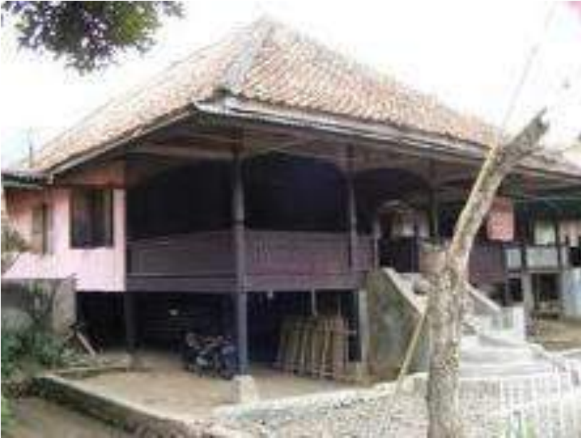
Gambar 2. Salah satu bentuk rumah tradisional di Liwa Kabupaten Lampung Barat. (Dokumentasi: Ani Suryani, 2009).
